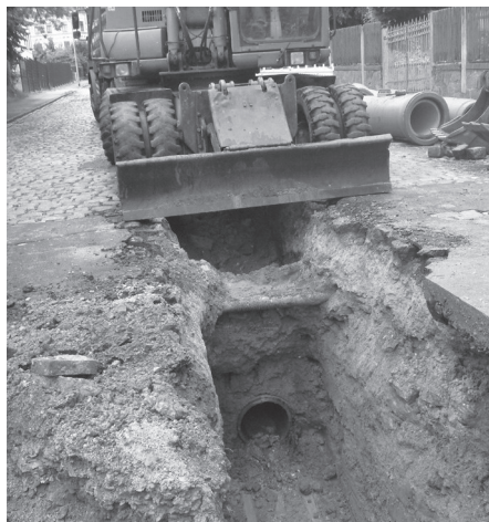
Altkanal in der Schmiederstraße
