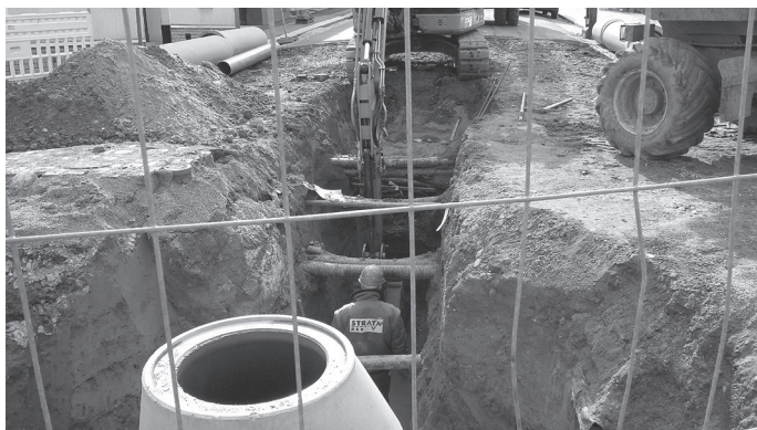
Arbeiten zur Verlegung des Abwasserkanals in der Oststraße
