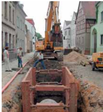
„Hauptsammlerverlegung in der Zwickauer Straße“
