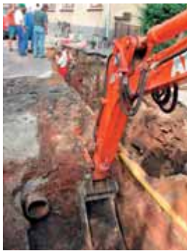
„Anbindung von Hausanschlüssen im Merlacher Weg“
