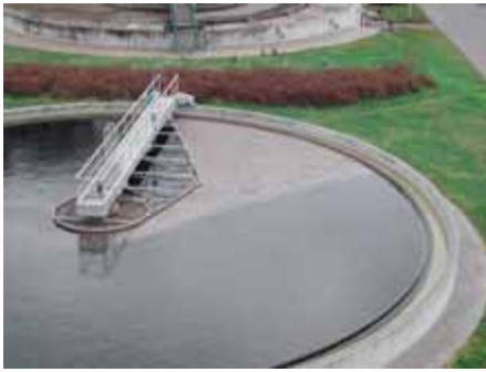
„Nachklärbecken: die im Uhrzeigersinn fahrende Räumerrücke schiebt den Schwimmschlamm vor sich her“
