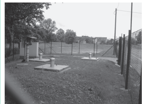
„Trennbauwerk mit nachgeschaltetem Erdbecken im Hintergrund“
