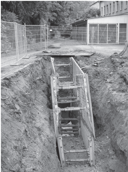
„Vorbereitung der Baugrube für die Kanalverlegung“
