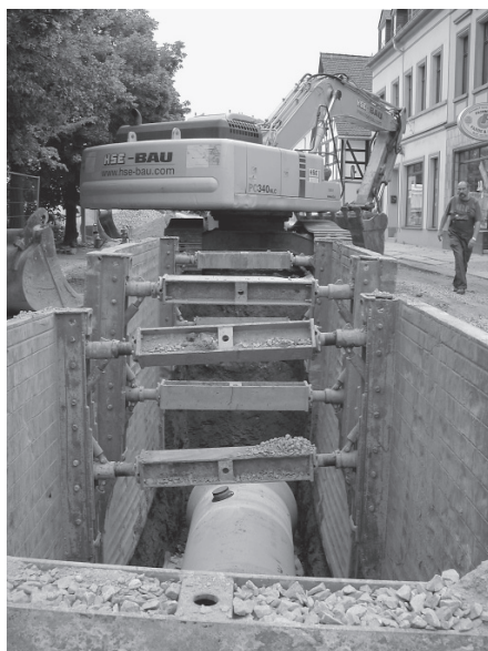
„Verlegung des Hauptsammlers in der Zwickauer Straße“
