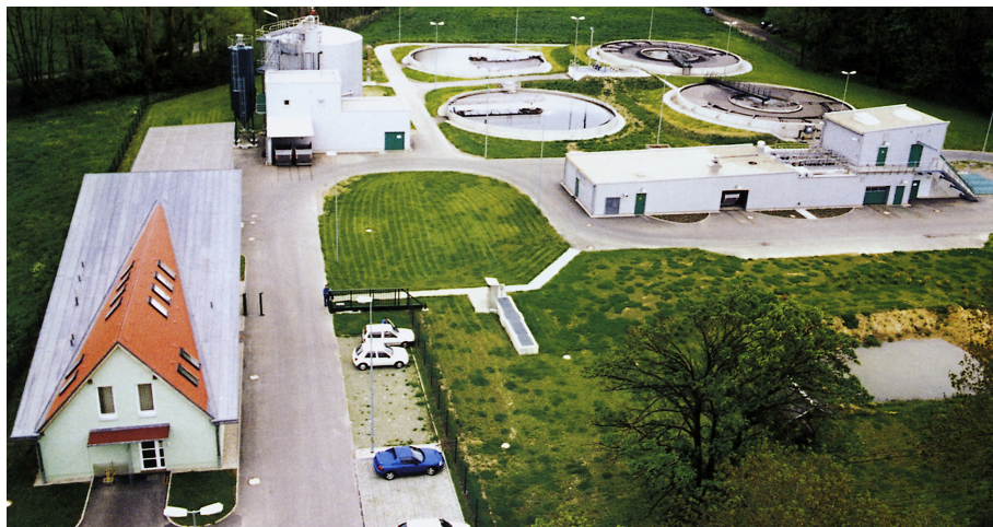
Kläranlage im Götzenthal
